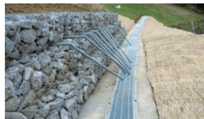
集水工 寺岡地区
