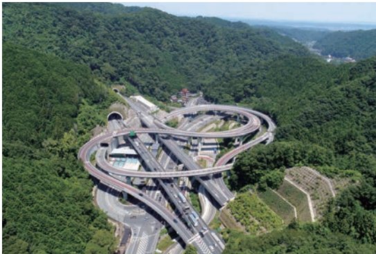
圏央道 高尾山インターチェンジ
