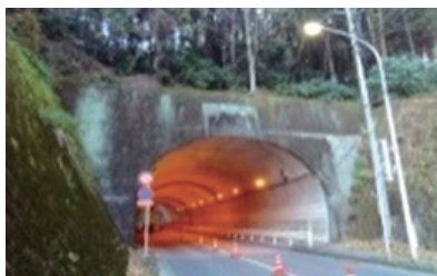
青梅坂トンネル
