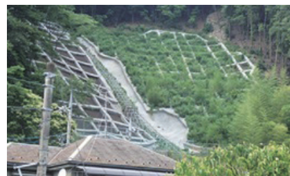
法枠工 高尾地区
