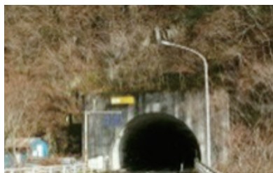
日原トンネル
