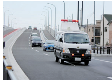
国分寺市内藤一丁目付近
