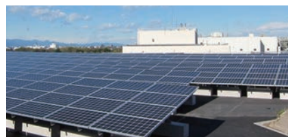
南多摩水再生センターの太陽光発電設備
