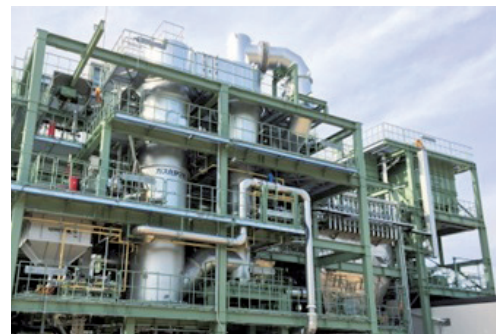
汚泥ガス化炉(南多摩水再生センター)
