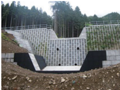
砂防堰堤工 海沢川
