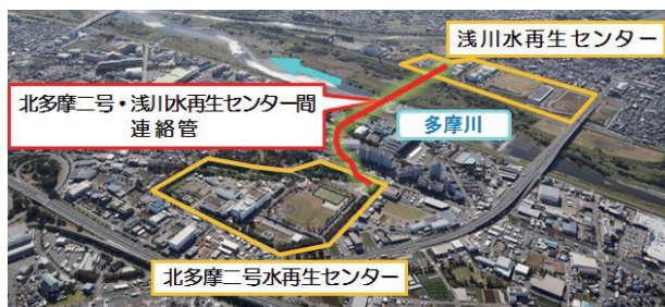
北多摩二号・浅川水再生センター間連絡管
